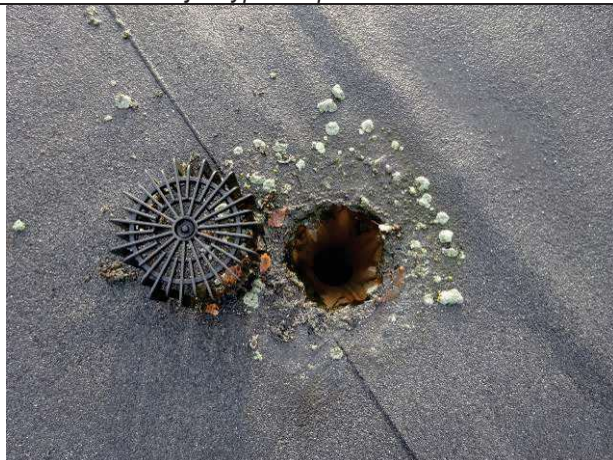
Obr. č. 33: Vpust V8 – atypický (kónický) tvar, střecha G
