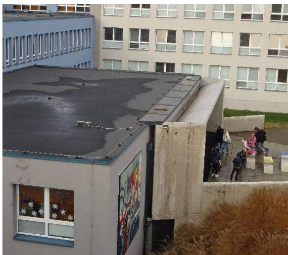
Obr. 18: Oplechování nad hlavním vstupem (DET. 11)
