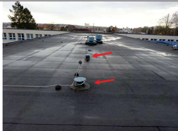
Obr. č. 11: Stávající prostup TZB Ø150 mm
