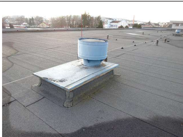
Obr. č. 19: Stávající ventilační hlavice CAGI Ø400 mm (č. 9) na betonové nástavbě (č. 6), střecha G
