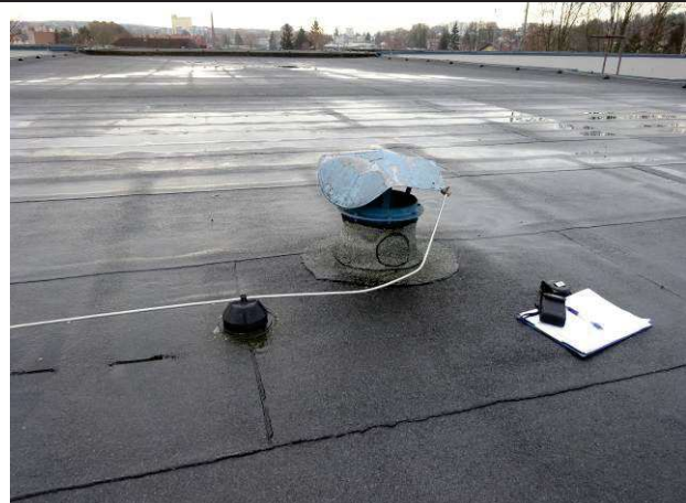
Obr. č. 12: Stávající prostup TZB Ø250 mm, střecha B
