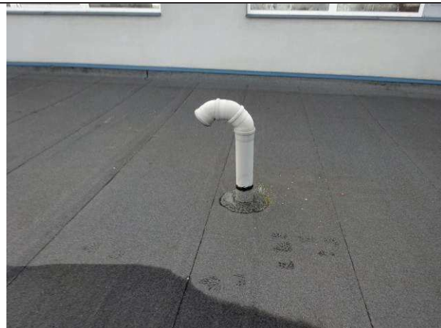
Obr. č. 18: Stávající průstup TZB Ø125, střecha H
