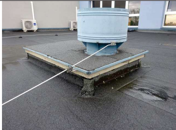
Obr. č. 15: Stávající ventilační hlavice CAGI Ø350 mm (č. 4) na betonové nástavbě (č. 6)
