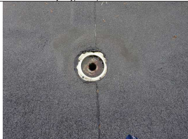
Obr. č. 32: Stávající vpust Ø45mm (V13). V4 má též průměr 45 mm.
