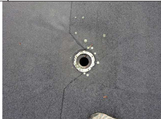
Obr. č. 30: Stávající typická vpust Ø70mm
