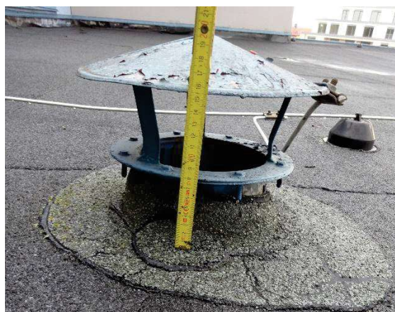
Obr. 17: Odvětrání TZB – bude nahrazeno novým systémovým komínkem (DET. 9)
