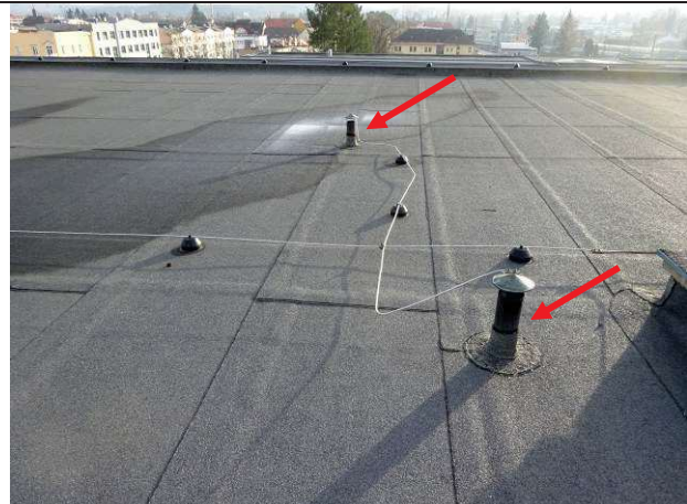
Obr. č. 14: Původní větrací komínek Ø100 mm, střecha G
