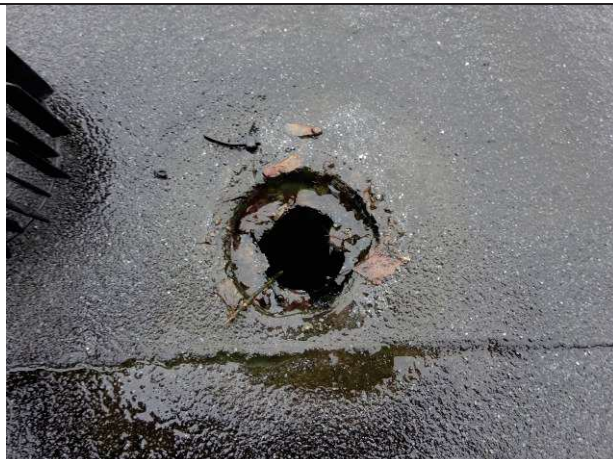
Obr. č. 31: Stávající typická vpust Ø70mm
