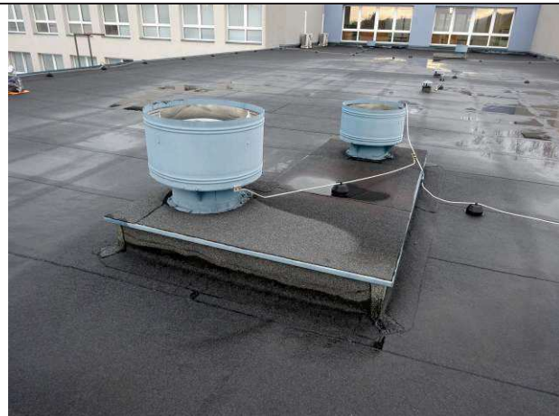
Obr. č. 20: Nástavba odvětrání - betonový podstavec tvaru "L", obrys 1600 x 2450 mm (střecha B)
