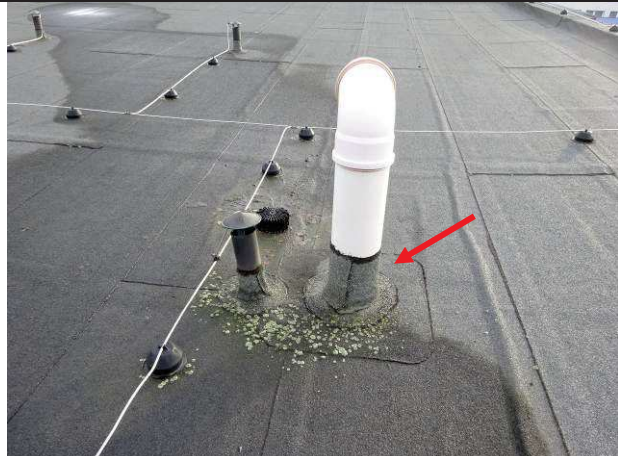
Obr. č. 13: Stávající prostup TZB Ø 250 mm, střecha G
