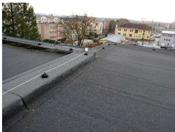
Obr. 11: Dělicí atika mezi střechami C a F
